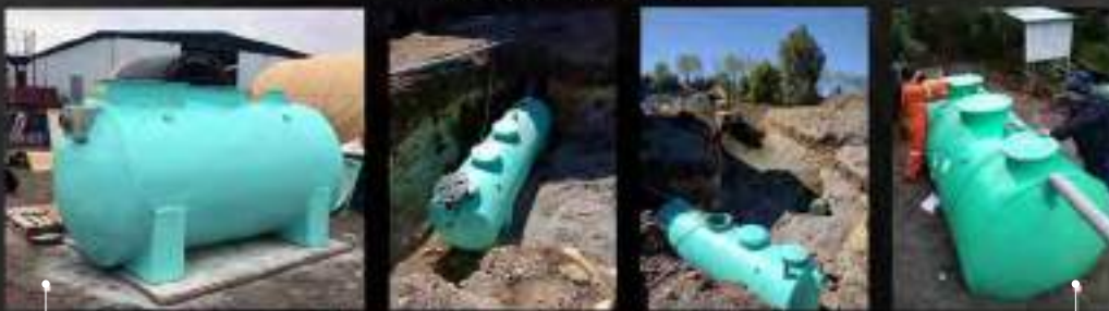
Plantas de Tratamiento Lodos Activados
